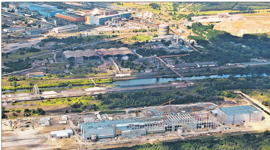
Bewegung im Industriegebiet: In Nachbarschaft vom Stahlunternehmen ArcelorMittal – nur durch den Oder-Spree-Kanal getrennt – entsteht die deutschlandweit größte Fabrik zur Herstellung von Wellpappenrohmaterial. Am unteren Bildteil, versteckt zwischen den Bäumen, verläuft die Bahnstrecke des RE 1. Foto: Bernd Geller
