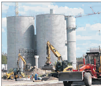
Aufbau-Arbeit: Die Teile der Abwasseranlagens sind bereits weithin sichtbar.
