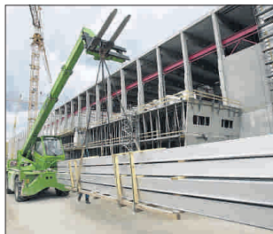
Robbau: Hinter dem Material, das gerade herangefahren wird, sieht man das Verwaltungsgebäude mit schräger Seitenfassade.
