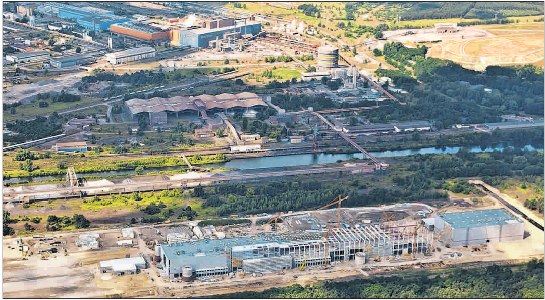
Bewegung im Industriegebiet: In Nachbarschaft vom Stahlunternehmen ArcelorMittal – nur durch den Oder-Spree-Kanal getrennt – entsteht die deutschlandweit größte Fabrik zur Herstellung von Wellpappenrohmaterial. Am unteren Bildteil, versteckt zwischen den Bäumen, verläuft die Bahnstrecke des RE 1. Foto: Bernd Geiler
